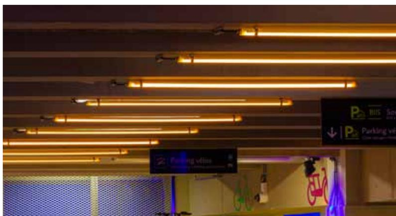
Tubulaire à LED 230V Ø40 mm finition inox. Idéal pour l'éclairage extérieur de mise en valeur, de balisage, de circulations ou architectural, l'éclairage tertiaire de lieux de travail et de vie, de halls et de circulations, de zones techniques et de parkings.
